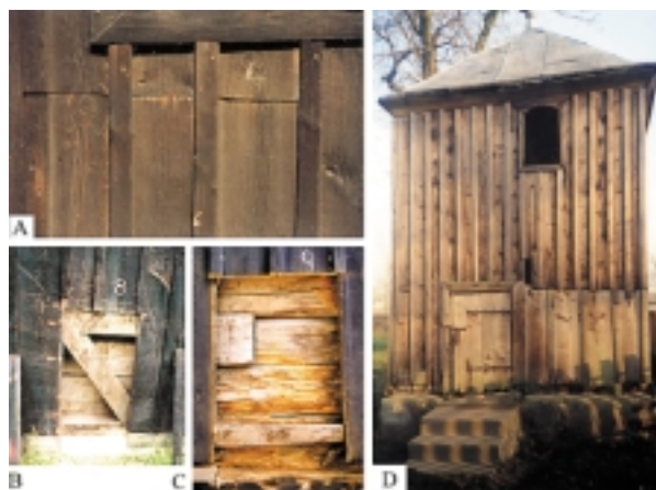
Ryc. 5. Kościoły drewniane. Metoda „badań architektonicznych” (A, B, C). Dzwonnica z wymienionym częściowo deskowaniem (D)
