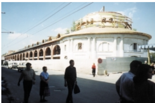
Riady w trakcie rewaloryzacji, prace wykończeniowe (fot. Jan Wrańa)
