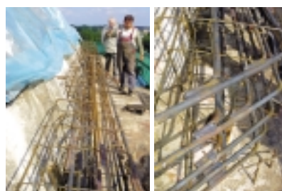
Rys. 20. Zbrojenie pierścienia dolnego, rozciągane
