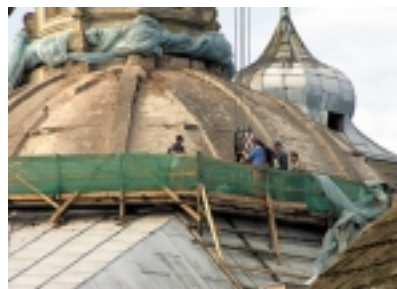
Rys. 18. Kopuła ceglana z żebrami w widoku z zewnątrz
