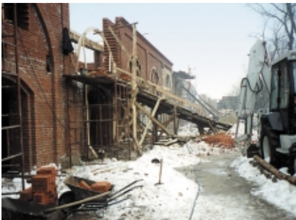
Początek rewaloryzacji, uzupełnianie murów (fot. Jan Wrańa)
