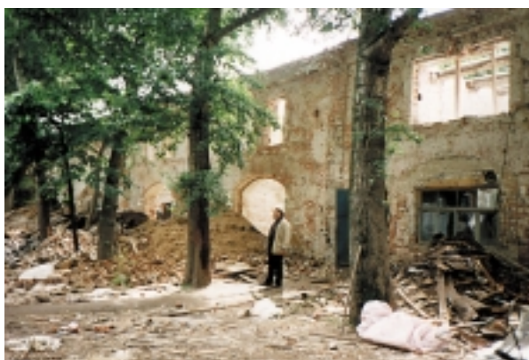
Początek rewaloryzacji, po zdjęciu zniszczonych tynków (archiwum JW. PROINVEST)
