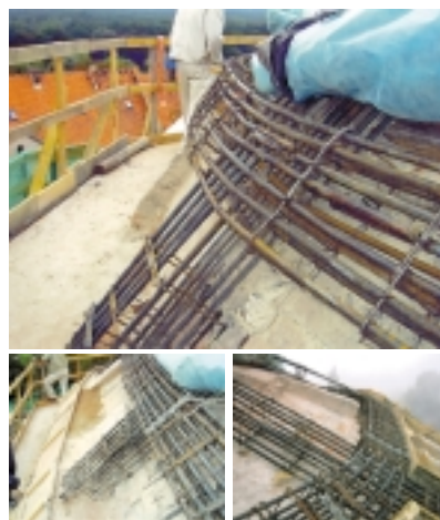
Rys. 21. Zbrojenie drugiego, trzeciego i czwartego żebra równoleżnikowego wraz ze zbrojeniem żeber południowych
