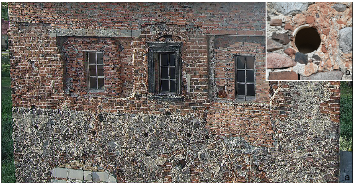
Ryc. 9. Zamek w Witkowie – wieża, a – naczynia ceramiczne wmurowane w elewację południowo-wschodnią, stan z 2020 r. (fot. B. Gruszka); b – zbliżenie jednego z naczyń (fot. A. Michalak).
