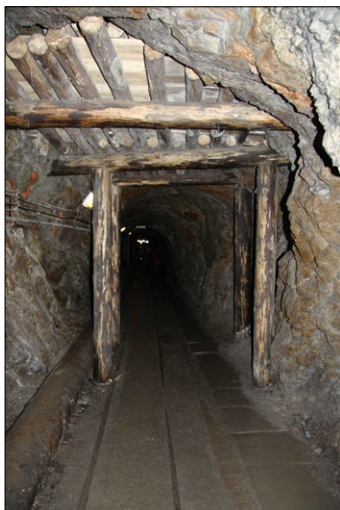
Ryc. 3. Kryterium integralności (kompletność) – obudowa drewniana od-rzwiowa w wyrobisku korytarzowym, kopalnia złota w Złotym Stoku.
