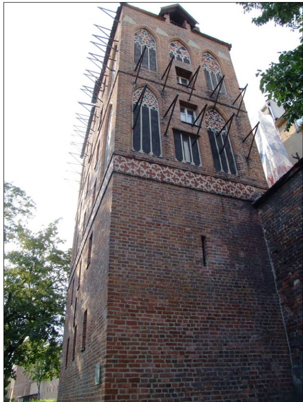
Ryc. 5. Baszta Golebnik – górny fragment elewacji wschodniej, 2020. Fig. 5. Golebnik Tower – the upper part of the eastern facade, 2020.
