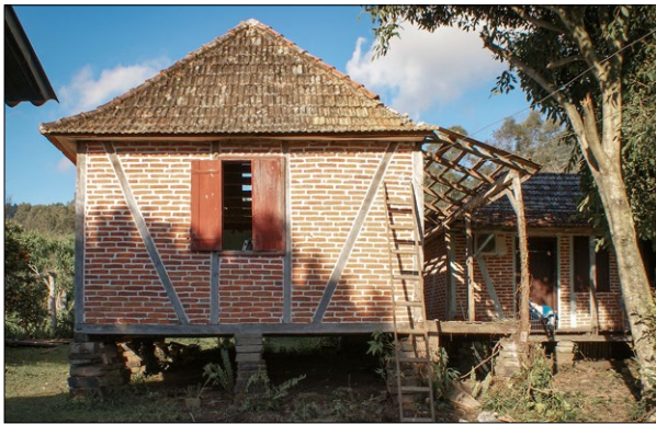
Ryc. 9. Dwa obiekty w konstrukcji szkieletowej w miejscowości Linha das Flores, gm. Agudo, o charakterze hybrydowym, zdjęcie wykonane w trakcie rozbiórki (2016).
