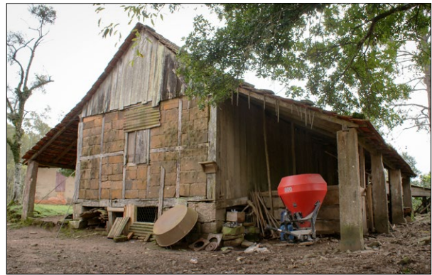
Ryc. 10. Pola drewnianej konstrukcji szkieletowej wypełnione blokami piaskowca, Linha das Pedras, gm. Agudo (2015).
