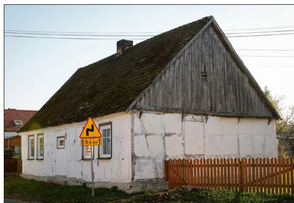
Ryc. 5. Budynek mieszkalny w Rakowie (daw. Rackow) nr 13, pow. szczecinecki (2018).
