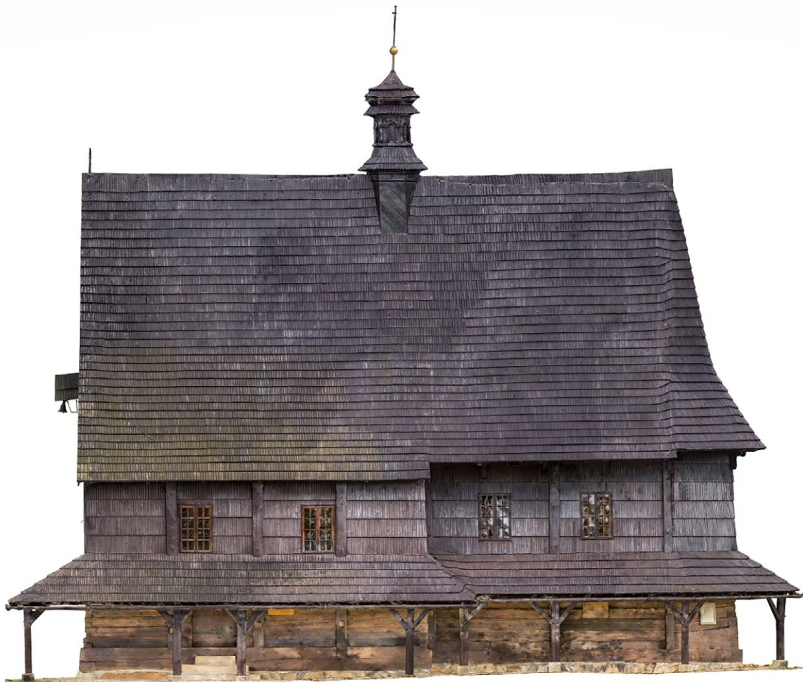
Ryc. 5. Elewacja kościoła, skan przestrzenny wykonany przez firmę 3delling, 2018. Fig. 5. Church facade, spatial scan performed by 3delling, 2018.
