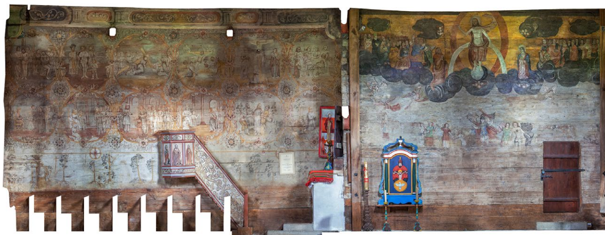
Ryc. 7. Północna ściana kościoła, skan przestrzenny wykonany przez firmę 3deling, 2018.
