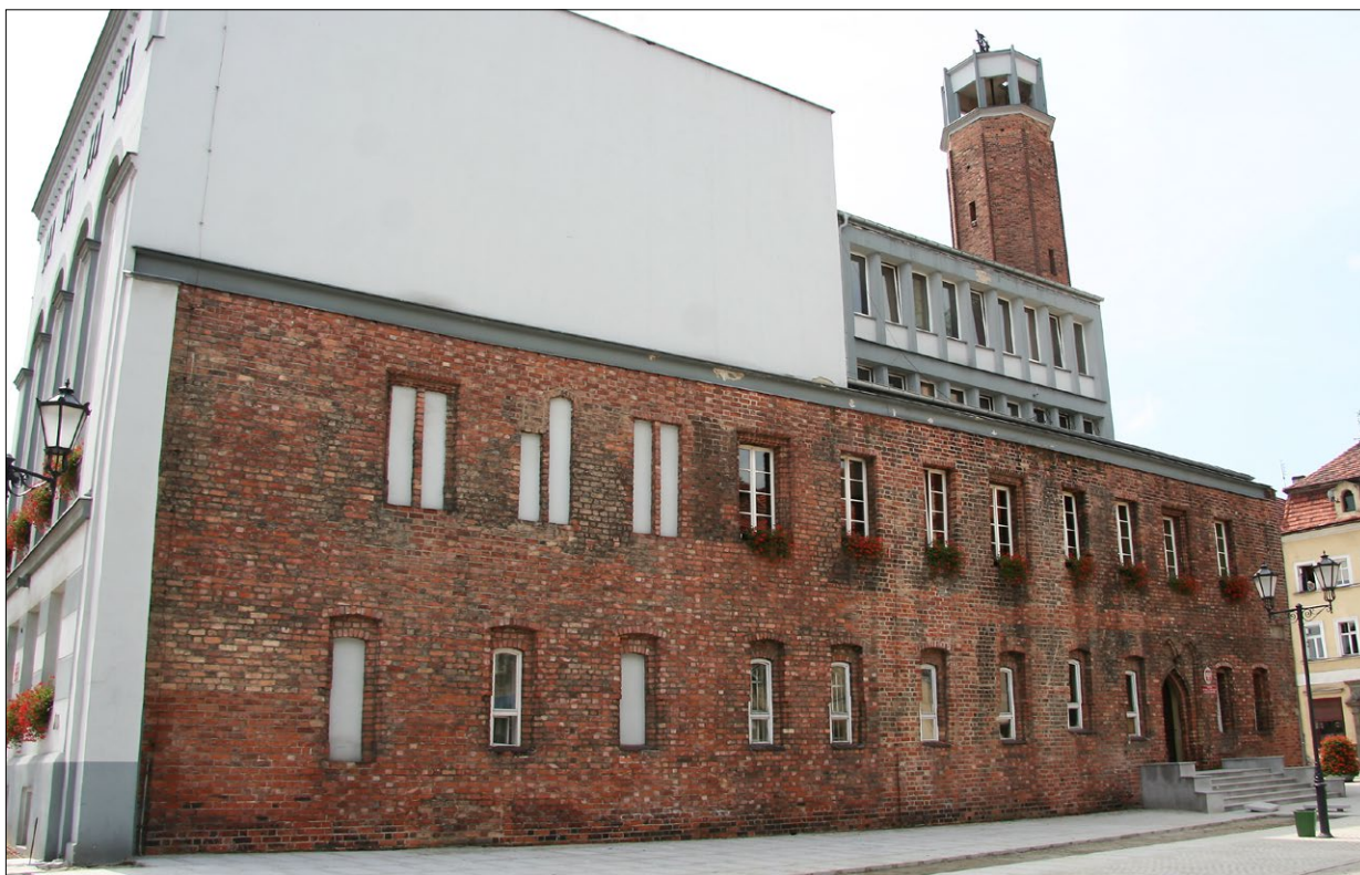
Ryc. 2. Ratusz w Koźuchowie, elewacja północna, widok od północnego wschodu, rok 2015; fot. A. Legendziewicz. Fig. 2. Koźuchów, the town hall, the north elevation seen from the northeast, 2015; photo by A. Legendziewicz.
