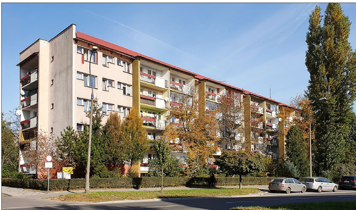
Ryc. 3, 4. Obecnie osiedle Krowodrza Górka w Krakowie (dawniej XXX-lecia PRL), widok bloków od strony skrzyżowania ulic Wybickiego i Władysława Łokietka (południowo-zachodniej) oraz jeden z bloków mieszkalnych; fot. M.J. Żychowska.
