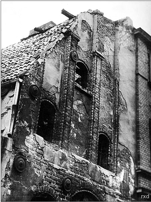
Ryc. 6. Szczyt kamienicy przy ul. Rabińskiej 24; oznaczenia: A – przed podjęciem prac w latach 50. XX w. z widocznymi konsolkami szczytu półkolisteo (zbiory Katedry Konserwatorstwa); B – po pracach odtwarzających błędnie szczyt schodkowy; fot. M. Prarat 2019.
