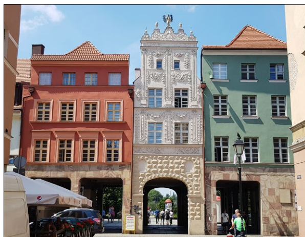
Ryc. 4. Rysunek elewacji kamienic przy ul. Piekary 35–39; oznaczenia: A – przed wybicciem bocznych przejazdów w 1936 w celu przeprowadzenia linii tramwajowej (rys. ze zbiorów Archiwum Państwowego w Toruniu, Akta miasta Torunia D, sygn. 2702, k. 20), B – fotografia stanu współczesnego, po usunięciu linii tramwajowej w 1971; fot. M. Prarat 2020.
