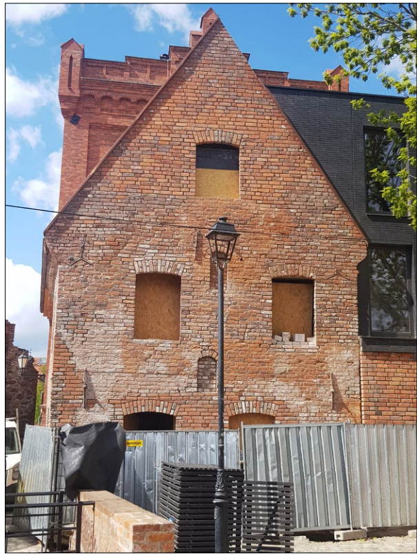
Ryc. 10. Elewacja frontowa budynku w sąsiedztwie zamku krzyżackiego; oznaczenia: A – przed pracami z widoczną strukturą średniowieczną i nowożytną, stan z 2017; B – po pracach, które zupełnie zniekształciły przekształcenia budowlane, stan z 2020; fot. M. Prarat.
