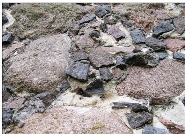
Ryc. 8. Rościszewo – zbliżenie na fragment ściany z widocznymi grudkami rudy darniowej, rok 2010; fot. R. Piotrowski. Fig. 8. Rościszewo—close-up of a wall fragment with visible bog ore fragments, 2010; photo by R. Piotrowski.
