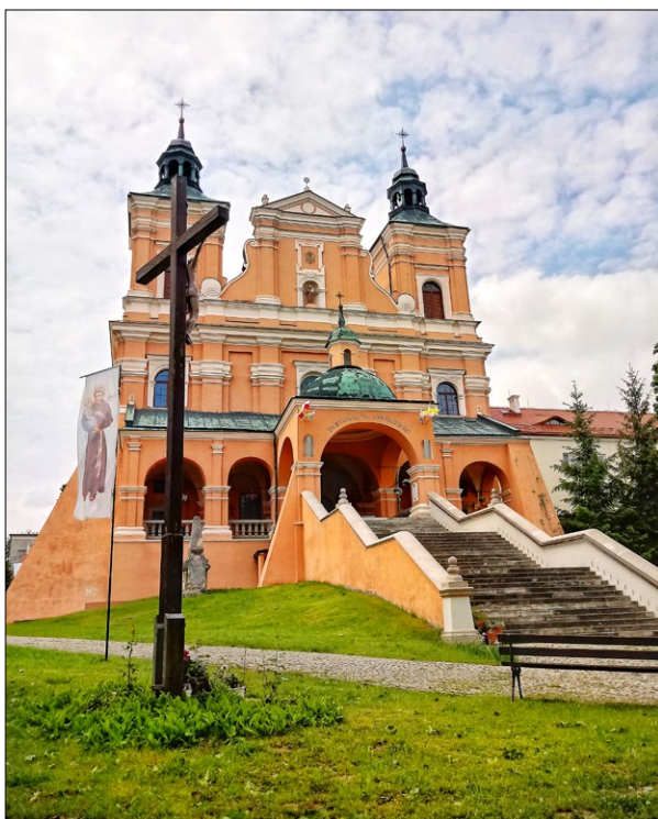
Ryc. 2. Bazylika w Radecznicy, fasada, arch. J.M. Link, rok 2020; fot. A. Mazurek. Fig. 2. Basilica in Radecznica, facade, arch. J.M. Link, 2020; photo by A. Mazurek.
