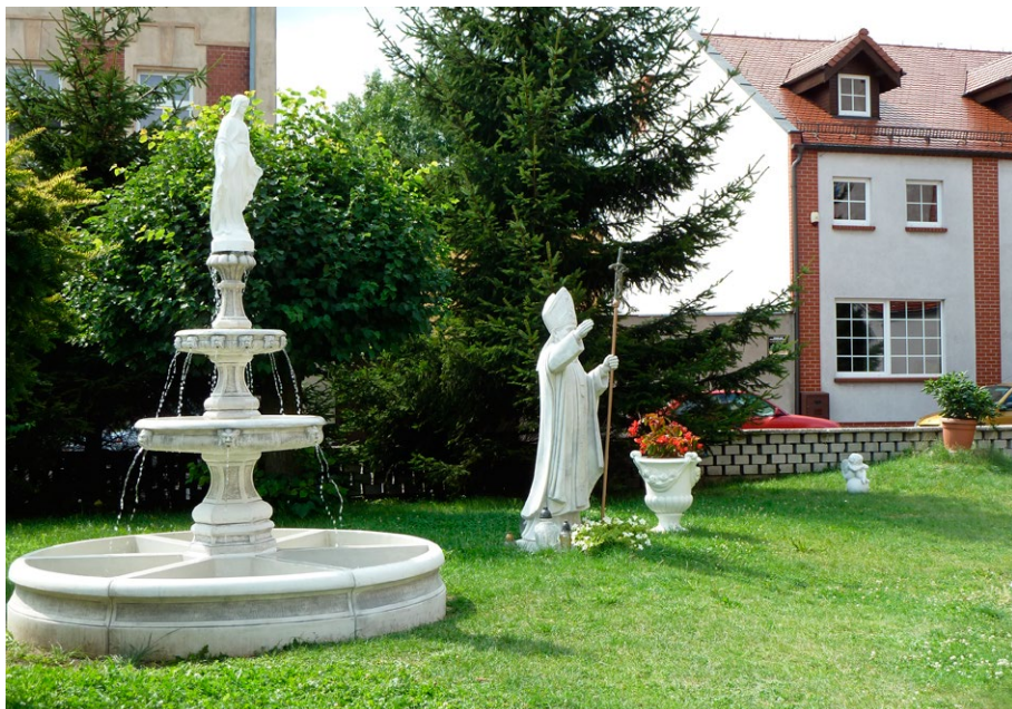
Ryc. 15. Niewłaściwe elementy małej architektury przy zabytkowym kościele (fot. J. Goszczyńska)
