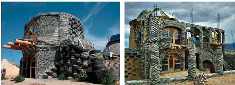
Ryc. 1 i 2. Przykład budynku z recyklingu; fot. Dameo Hudson / cc-by sa 3.0
