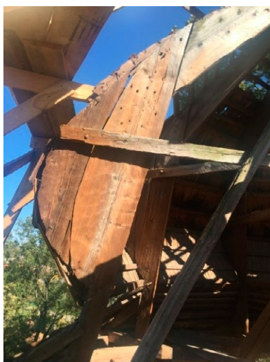
Rys. 9. Dzwonnica cerkwi św. Jura, obiekt po zakończeniu prac, detale konstrukcji. 2019, Foto S. Pińkowski
