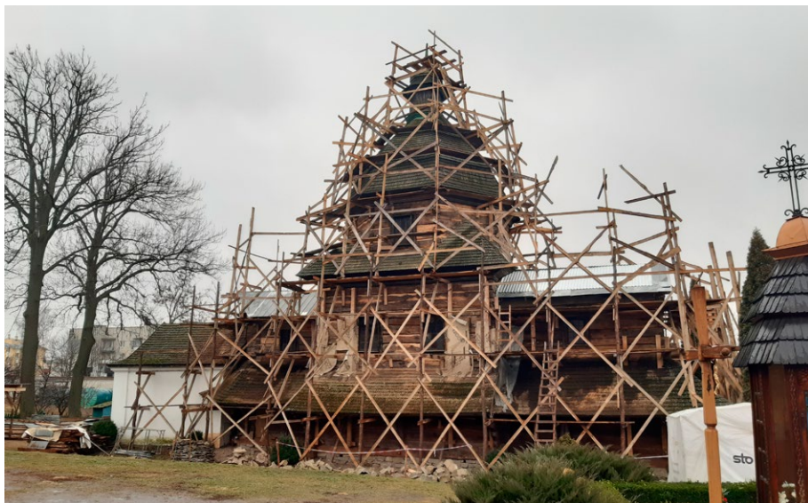
Ryc. 7. Cerkiew Świętej Trójcy w stanie częściowego demontażu, 2019; fot. autor
