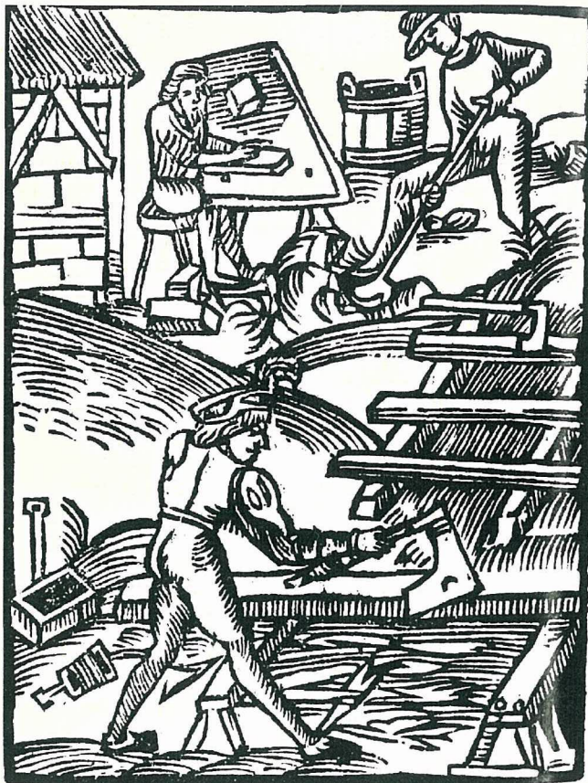
Roboty budowlane, drzeworyt z dzieła Piotra Crescentyna Księgi o gospodarstwie..., Kraków 1549
